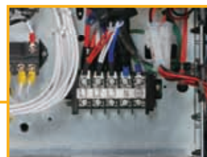
Przyłącza elektryczne jednostki zewnętrznej
